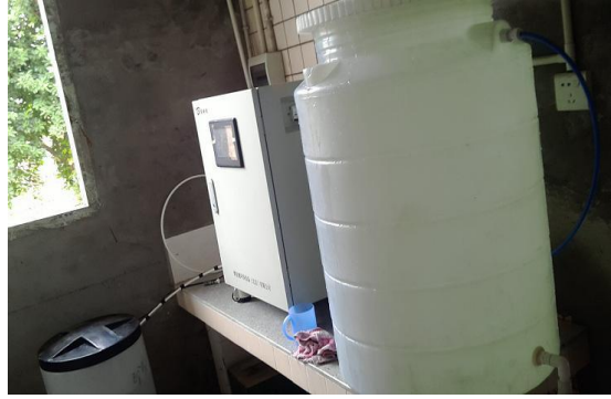
重庆畜牧科学院 猪场现场安装照片
